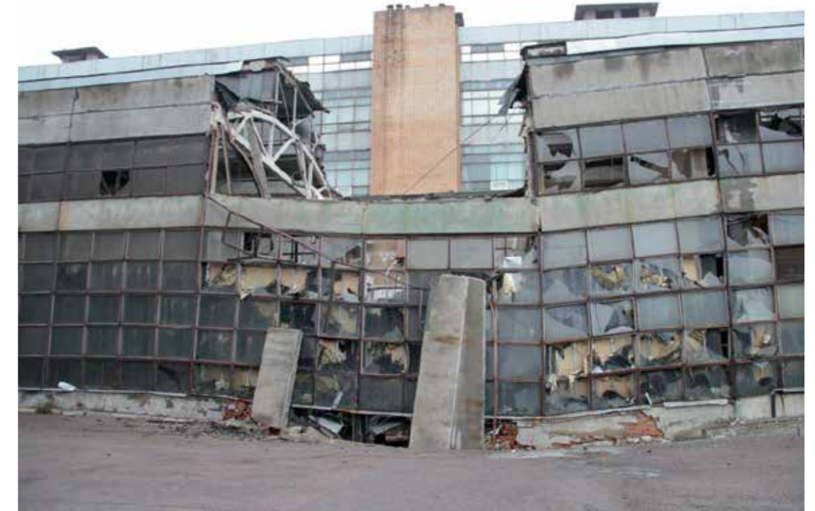
Рис. 1. Локальный провал основания столбчатого фундамента здания при проходке под ним тоннеля метрополитена
